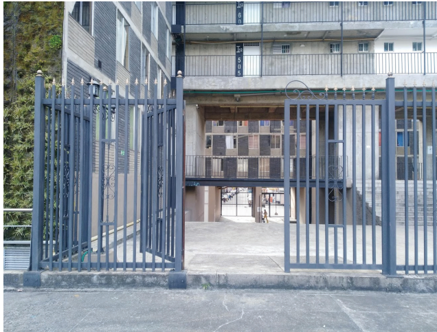
Imágenes 5 y 6. Rejas de seguridad añadidas al diseño original del proyecto. Fuente: Fotografías propias.
