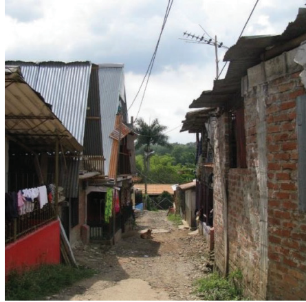
Imagen 7. Estado de las viviendas del centro poblado “La 18”. Fuente: Fotografía propia.
